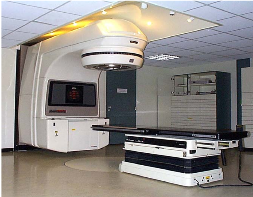
Fig. 10 : accélérateur linéaire électrons-photons avec le bras isocentrique et la table de radiothérapie
